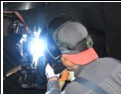
⑩ 分解後の本溶接 (プラグ溶接)
