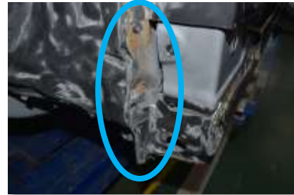
粗引き作業後の状態
