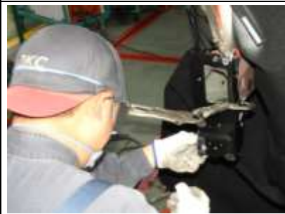
⑦ 新部品の仮組み
