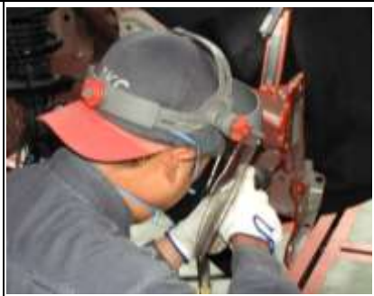
③ 損傷部位の取外し
