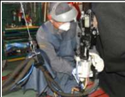
⑪ 本溶接 (スポット溶接)
