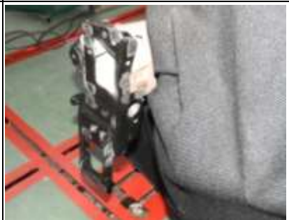
⑫ 取替溶接作業終了
