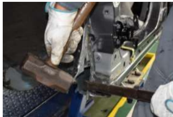
バールを使用した作業
