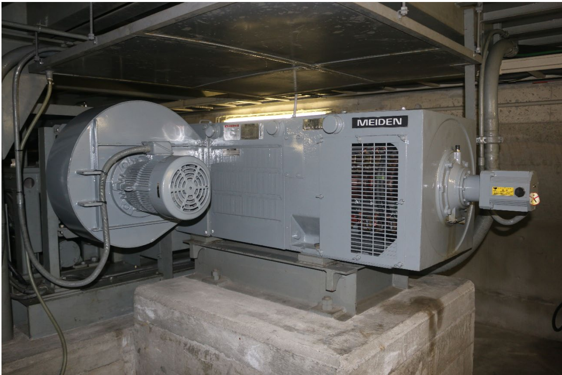
動力モータ（出力 150kW 、重量 1290kg）
