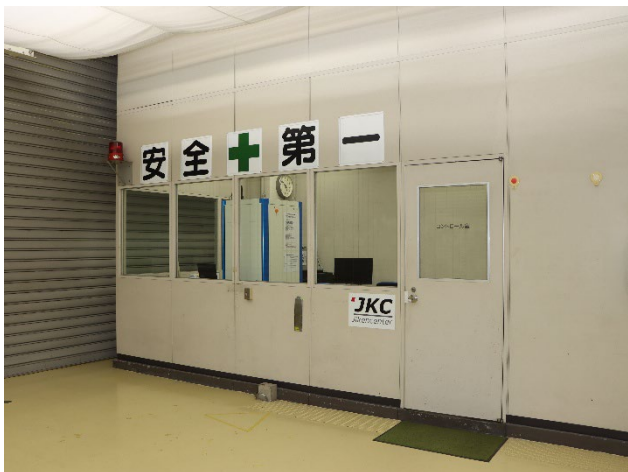
コントロール室
