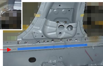
■: 補強パネル取替時、リベット接合箇所
