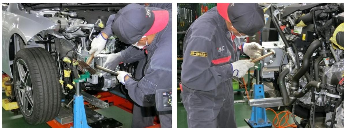
修正したナットプレートプラグ溶接でサイドメンバに取付けます。
