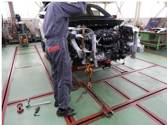
チェーンブロックを使用し、右フロントサイドメンバの先端を真下方向へ引き、高さを修正する。
