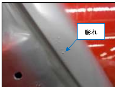
④ 膨れが生じている
