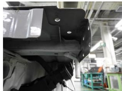
パネル C の板金が完了
