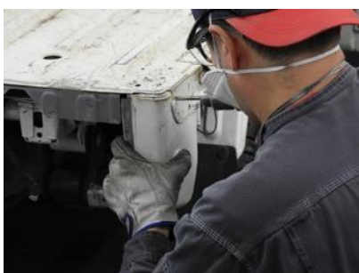
側面のスポット溶接 4 点を切削
