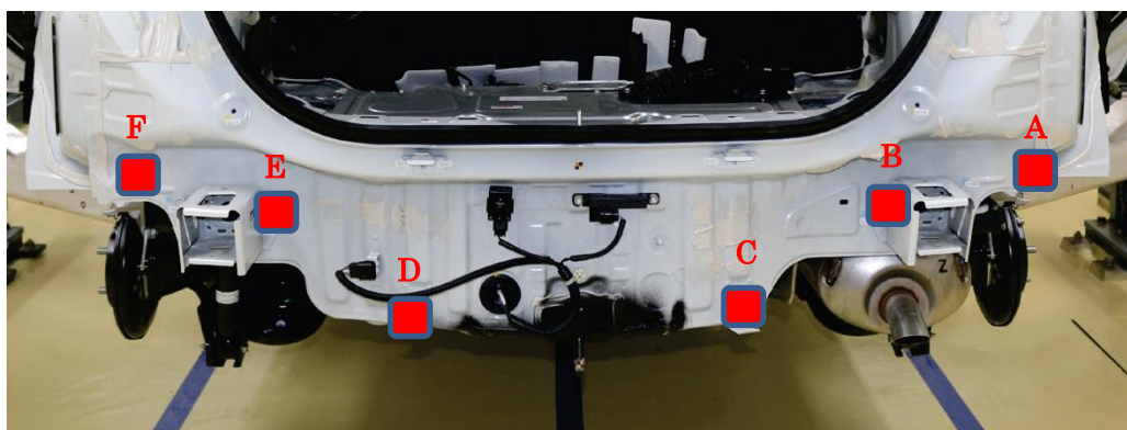
フィット (GR3) の損傷状態
