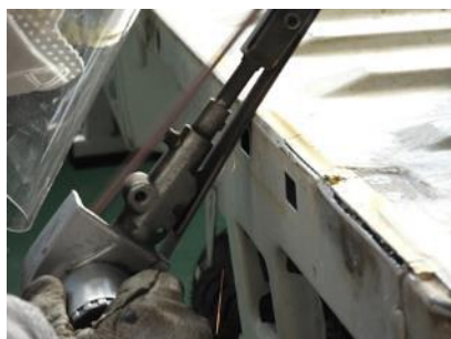
境界線より後方の角部を削る
