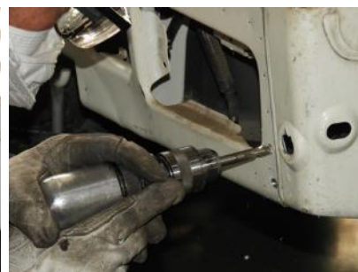
スポット溶接点を切削
