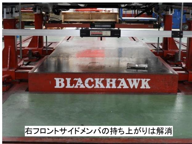
5回目の引き作業の結果確認、右フロントサイドメンバの持ち上がりは解消、基準値内を確認し、右側の基本修正作業は終了。この後、左フロントサイドメンバの振れ修正を行う。
