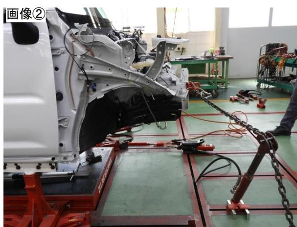
左フロントサイドメンバの左方向への振れ修正のため、先端内側へクランプ（画像①）の上、2時半方向水平引き（画像②）にて修正を行う。
