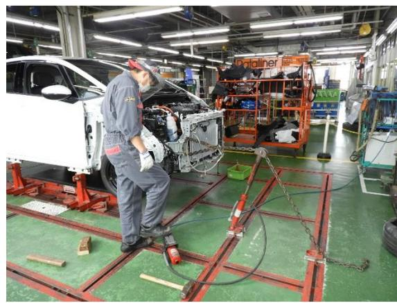
・右フロントサイドフレーム先端フランジ部とバルクヘッドの間にチェーンを巻付け、少し角度（12時半方向）をつけて引き作業を実施、1回目同様大きな力が伝わらず、引きは不十分な状態。
