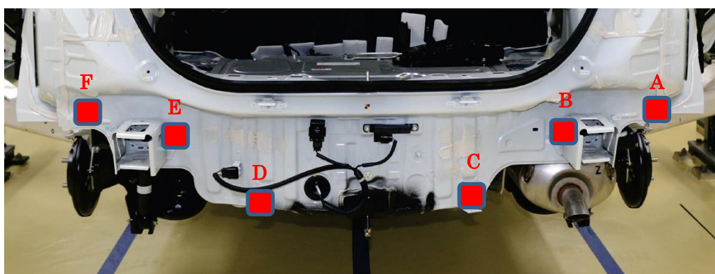
フィット (GR3) の損傷状態
