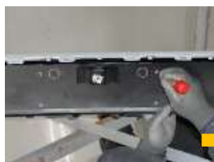
取付位置にセンタポンチで印付け
