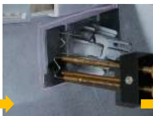
拡大（溶着作業）
