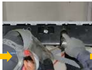
ホールソーで穴あけ
