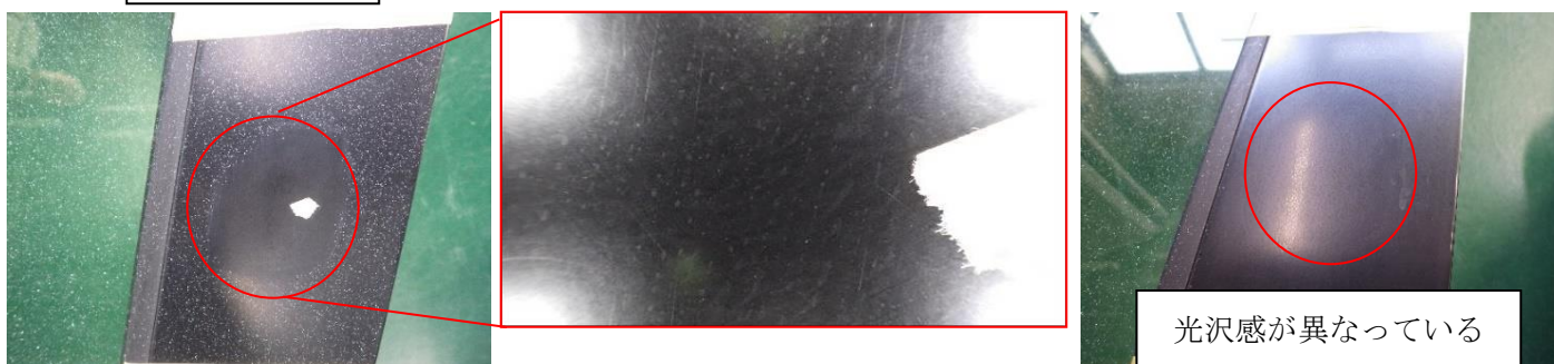
除去作業部分
