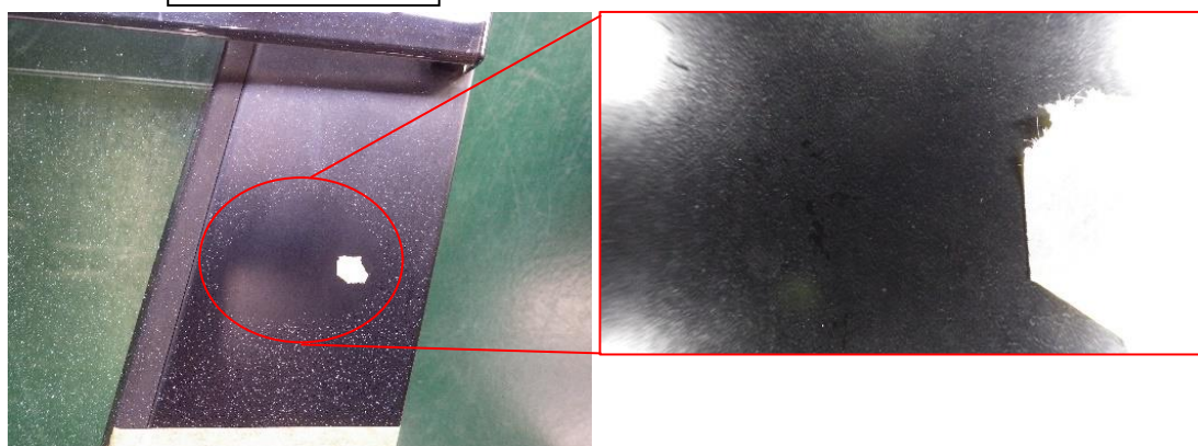
除去作業部分
