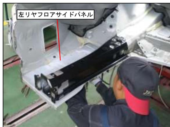
③ サイドメンバトウフロアラインホースを、左右リヤフロアパネルブレース、ボデーロワバックパネルと位置合せして取付けました。
