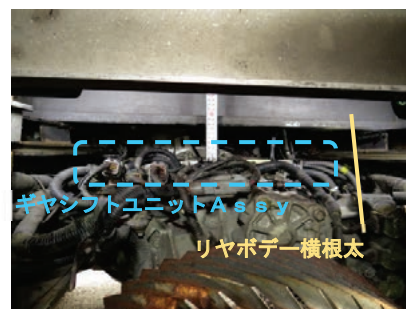
ギヤシフトユニット取付位置 (横根太との隙間：約7cm)
