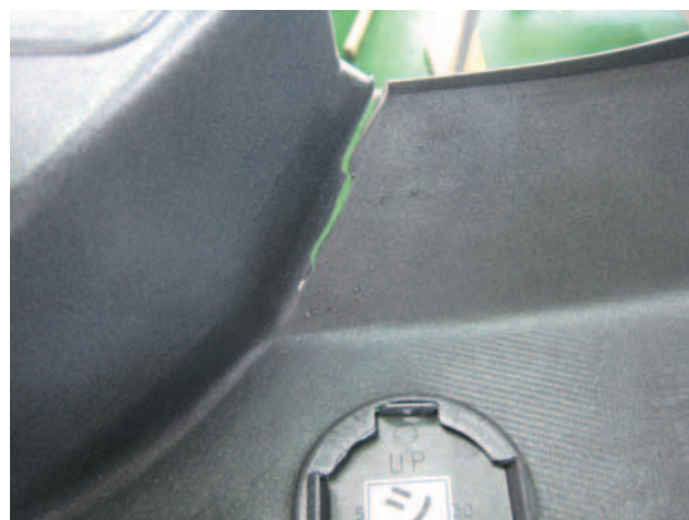
裂傷損傷の裏側
