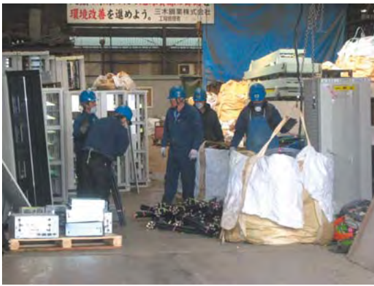
(解体処理作業)
