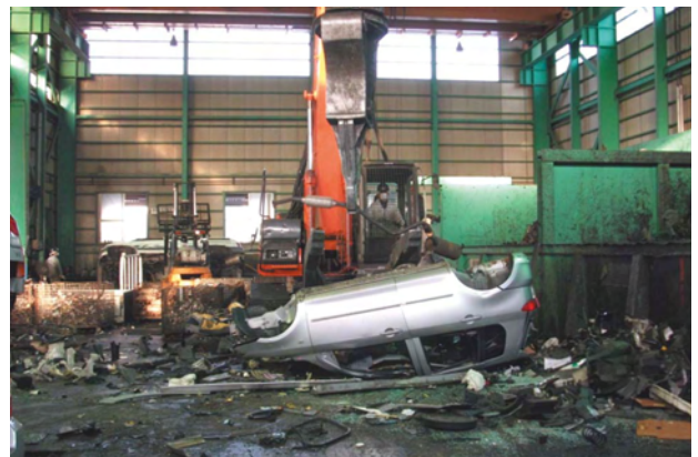
マフラの剥ぎ取り
