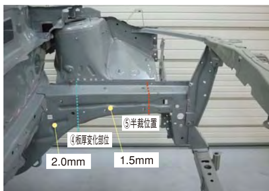
写真4 サイドフロントメンバ左内側
