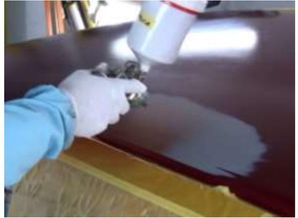
⑦水性塗装のため、ハンド式ブローガンで強制乾燥を行います。
