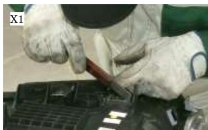
③ベルトサンダ等で切削した箇所を、カッターやスクレーパー等でバリを取除いて平滑に仕上げます。
