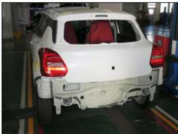
(3) バックパネルの取付位置が決まったので再度外装部品を取外して溶接しました。
