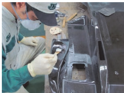
カーボンクロス貼付け面に樹脂を塗布します。
