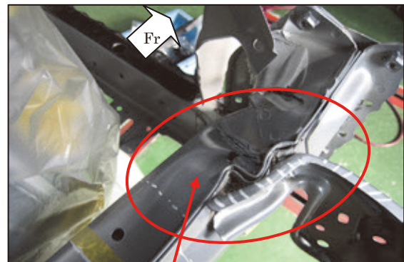
右フロントフレームサイドフロント COMP・引き作業後
