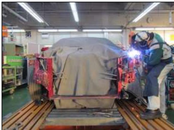
④溶接部位の取替作業が終了した状態です（溶接部は塗装済み）。
